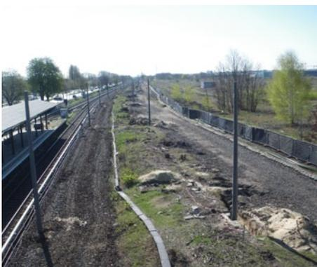
freigeräumt – die Arbeiten sind im Zeitplan. Demnächst beginnen die Arbeiten zur Herstellung des Gleisplanums, auf das dann das eigentliche Gleis aufgebaut wird. Inbetriebnahmetermin ist der Fahrplanwechsel Mitte Dezember 2015. Dann sollen hier die ersten Regionalbahnen zum Ringbahnsteig am Ostkreuz fahren.
